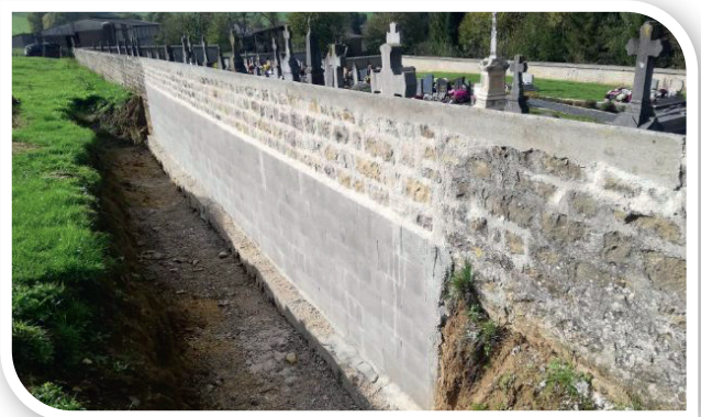
Le mur du cimetière de Les Deux-Villes
