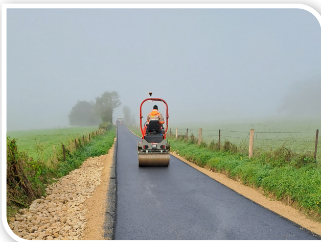
Les travaux se terminent sur la voie cyclable Carignan - Douzy
